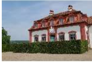
BaSee.I, Gärtnerhaus AF 1 (Nordfassade), DI014068, BSV-
