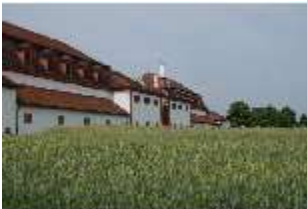
BaSee.I, Memmelsdorfer Tor (AF 3), Nordfassade, DI014058, BSV-
